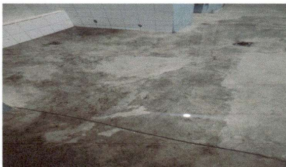
Foto1: Sustrución de piso de torta de concreto por piso ceramico.
