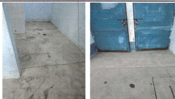
Foto 2: Sustrución de piso de torta de concreto por piso ceramico.
