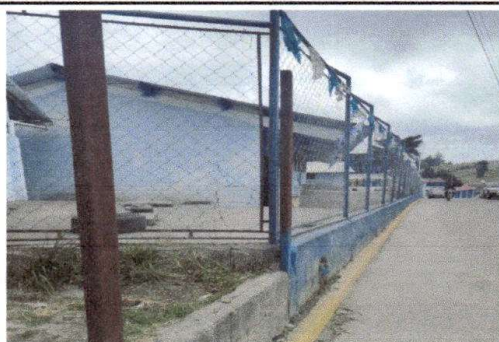
Foto 5: Reparación de muro perimetral de block con tubo hg y malla galvanizada, soleras intermedias y columnas.
