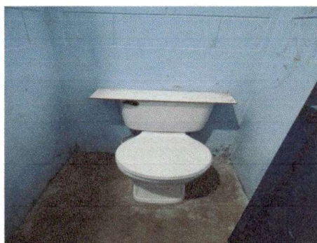
Foto 3: Sustitucion de inodoro.
